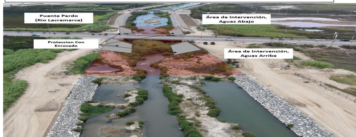
FIGURA N°03: Situado en el Río Lacramarca, se aprecia el cauce del río; la meta física consta de la descolmatación y conformación de dique con material propio y con enrocado en ambos márgenes del Río lacramarca a la altura del Puente de la Av. Pardo en una longitud de 180 ml aproximadamente.
