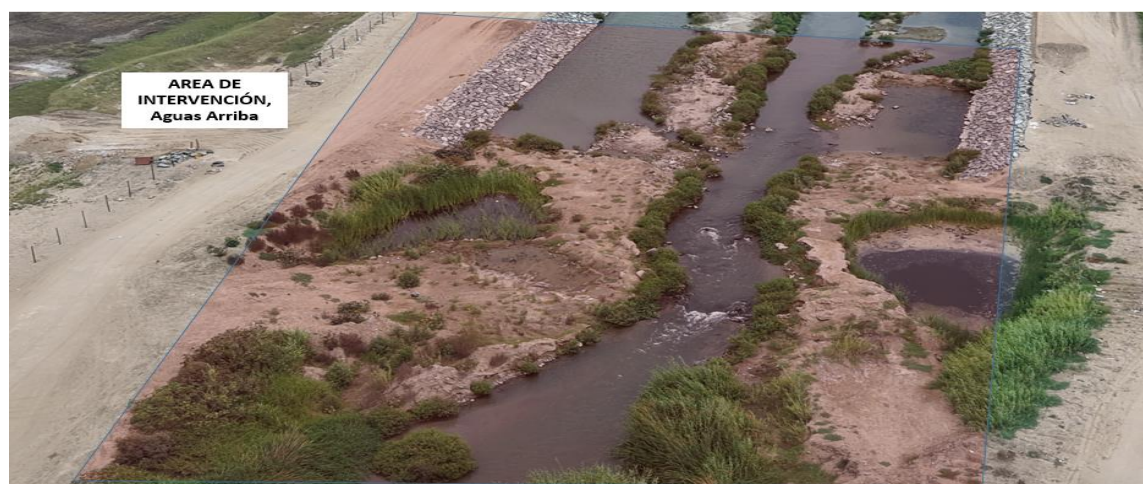
FIGURA N°02: Vista desde el dron Sobre el Puente Pardo, se aprecia el cauce del río Lacramarca. La meta física consta de la descolmatación y conformación de dique con material propio en ambos márgenes del Río Lacramarca en una longitud de 180 ml aproximadamente.
